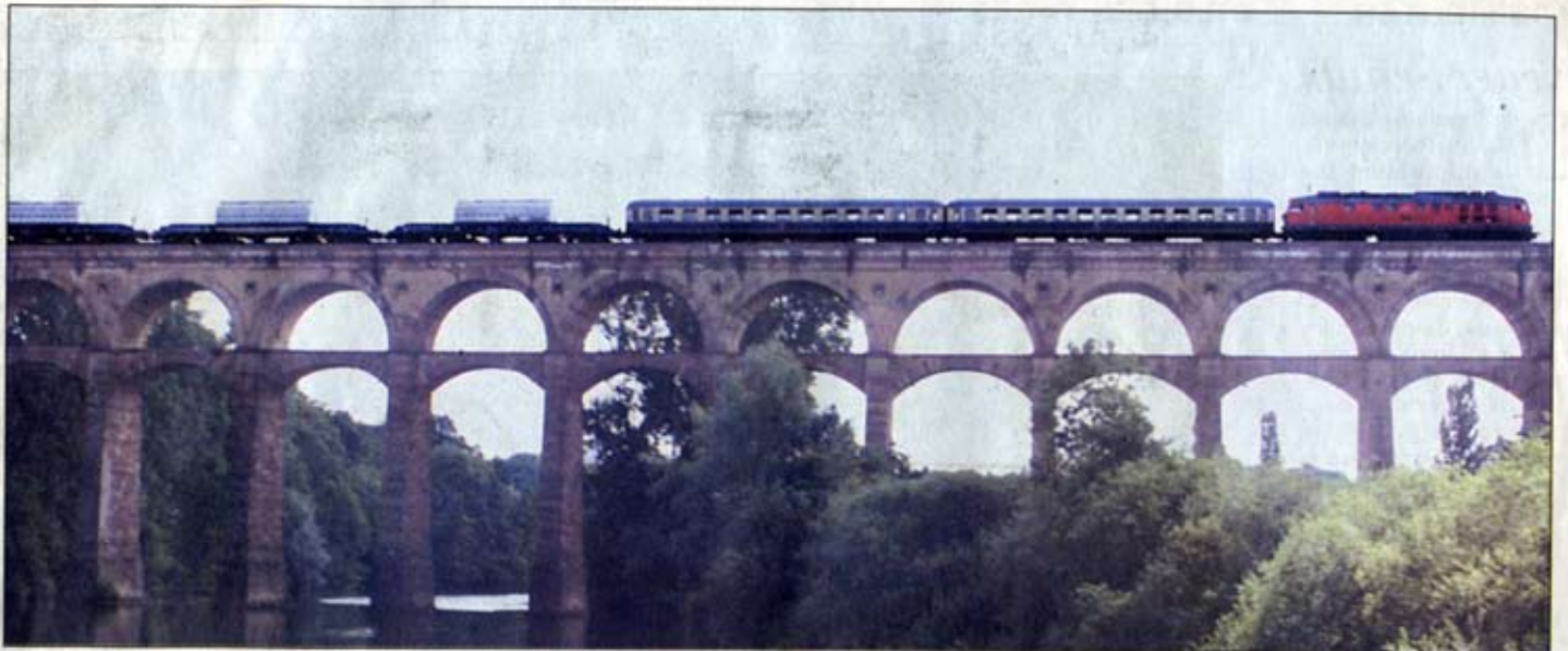
Atomtransport rollt ohne Störungen über das Viadukt in Richtung französische Grenze
